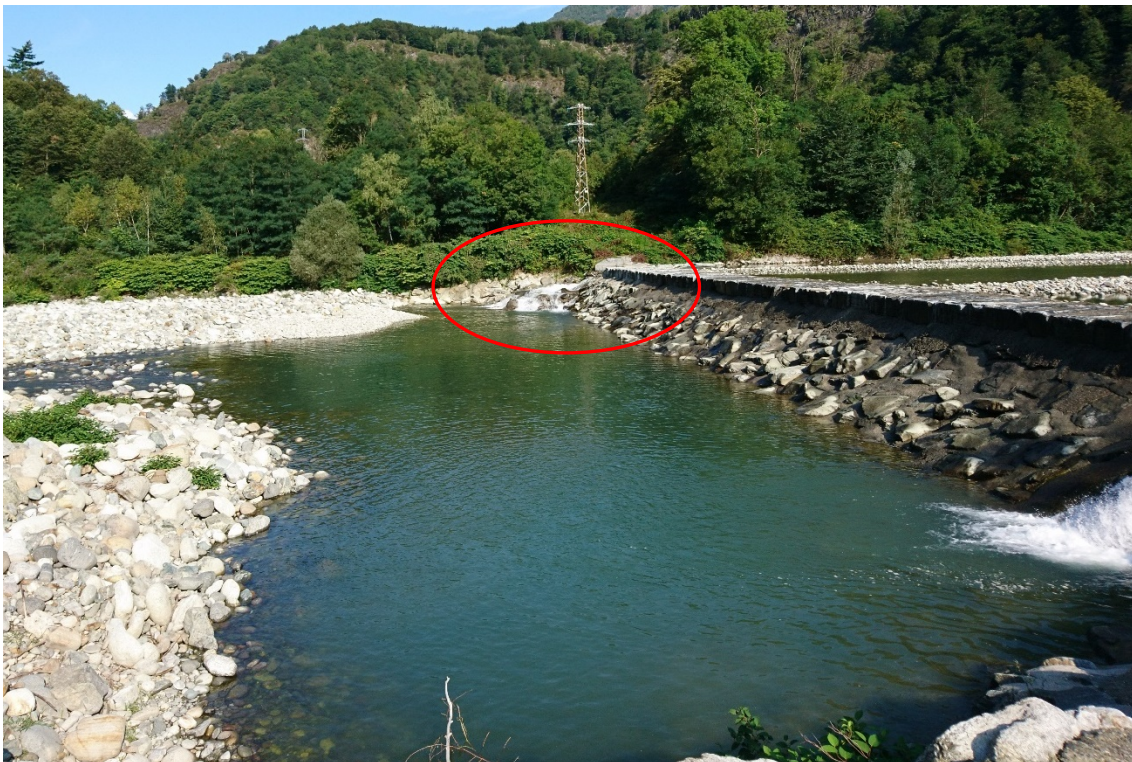
Figura 4: Discontinuità B - vista dalla traversa da valle, in sponda sinistra, nel cerchio rosso il passaggio per pesci.
