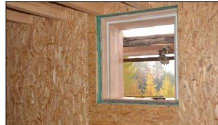
**E** Particolare finestra Interno con evidenza della posa del nastro sigillante.
