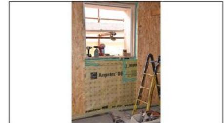
**C** Particolare finestra Interno con evidenza della posa del freno a vapore Ampatex osb.
