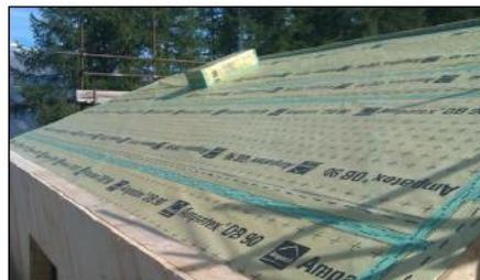
**H** Particolare tetto; freno a vapore Ampatex e nastri sigillanti Ampacoll.
