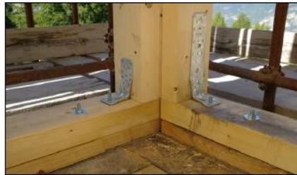
**E** Posa in opera delle strutture in legno con particolare della base e collegamenti.
