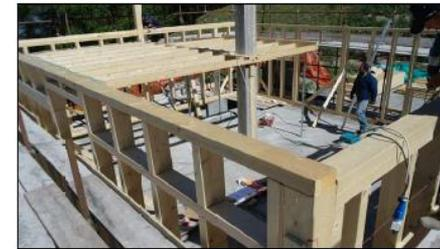
**F** Posa in opera delle strutture in legno con particolare del solaio piano primo e collegamenti.
