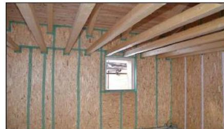
**H** Particolare finestra Interno con evidenza della posa del nastro sigillante su osb.
