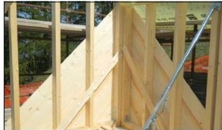
**B** Posa In opera del rivestimento In legno con evidenza del collegamenti.
