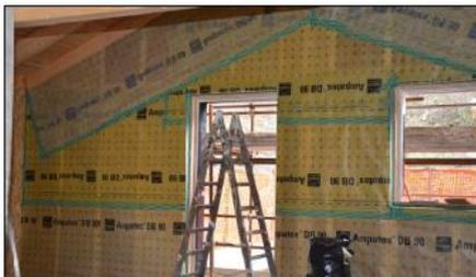
**G** Vista fronte sud con evidenza della posa del freno a vapore Ampatex.
