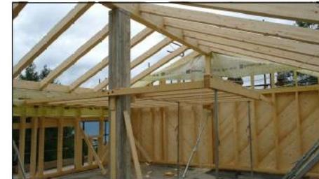
**C** Posa In opera del rivestimento In legno con evidenza del collegamenti.
