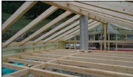
**A** Posa In opera delle strutture In legno con particolare del solaio piano primo, tetto e collegamenti.
