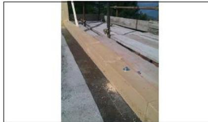
**B** Posa in opera delle strutture in legno con particolare della base.
