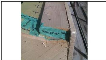
**G** Particolare banchina tetto; freno a vapore Ampatex e nastri sigillanti Ampacoll.
