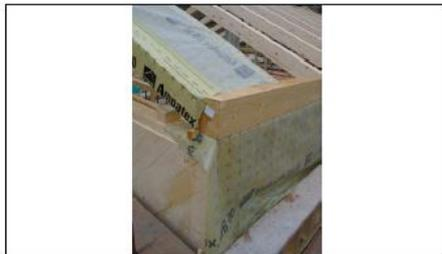
**D** Particolare tetto; con evidenza della continuità del freno a vapore Ampatex.
