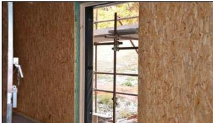
**D** Particolare porta Interno con evidenza della posa del nastro sigillante di unione freno a vapore telo su controtelaio.
