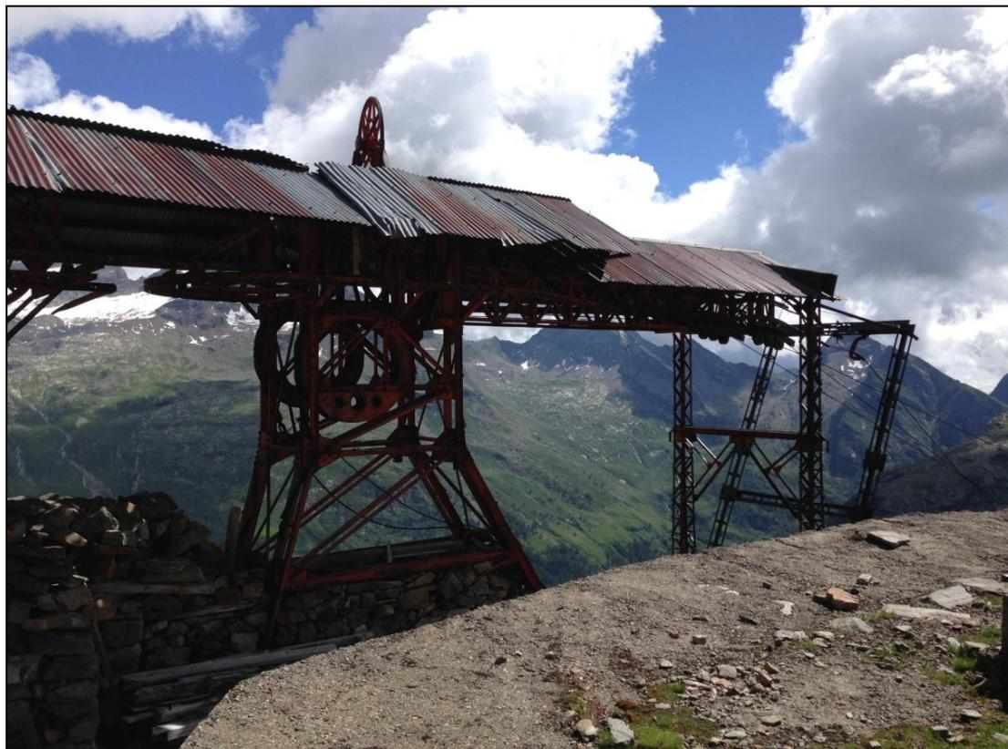
Sostegno 2 – Dettaglio della teleferica di prevista demolizione
