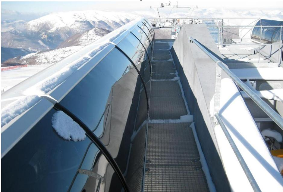
Al tetto della stazione si accede da una botola dall'interno. Come optional può essere previsto anche un'apposita scala di accesso dall'esterno. Per eseguire la manutenzione in sicurezza, sul tetto vi è installata una "linea vita" orizzontale, alla quale l'operatore, adeguatamente formato e addestrato, si aggancia con il dispositivo di protezione anticaduta (DPI anticaduta).
