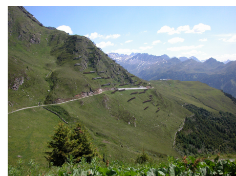
Esempi di opere di protezione da valanghe su versante aperto (zona di distacco) e bosco di protezione
