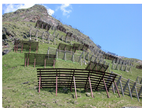
Esempi di opere di protezione da valanghe su versante aperto (zona di distacco) e bosco di protezione
