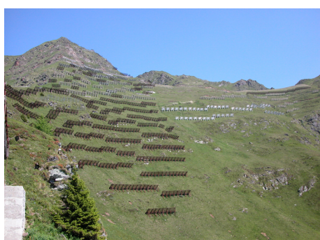
Esempi di opere di protezione da valanghe su versante aperto (zona di distacco) e bosco di protezione
