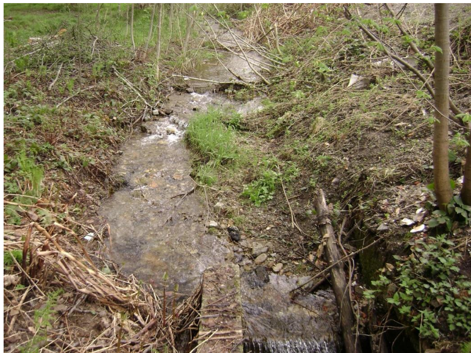
Canale a valle oggetto di sistemazione Tramite fondi ATO 2020
