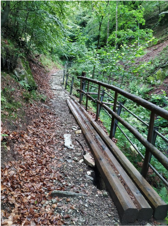
Tratto di mulattiera sbancato dalla frana
