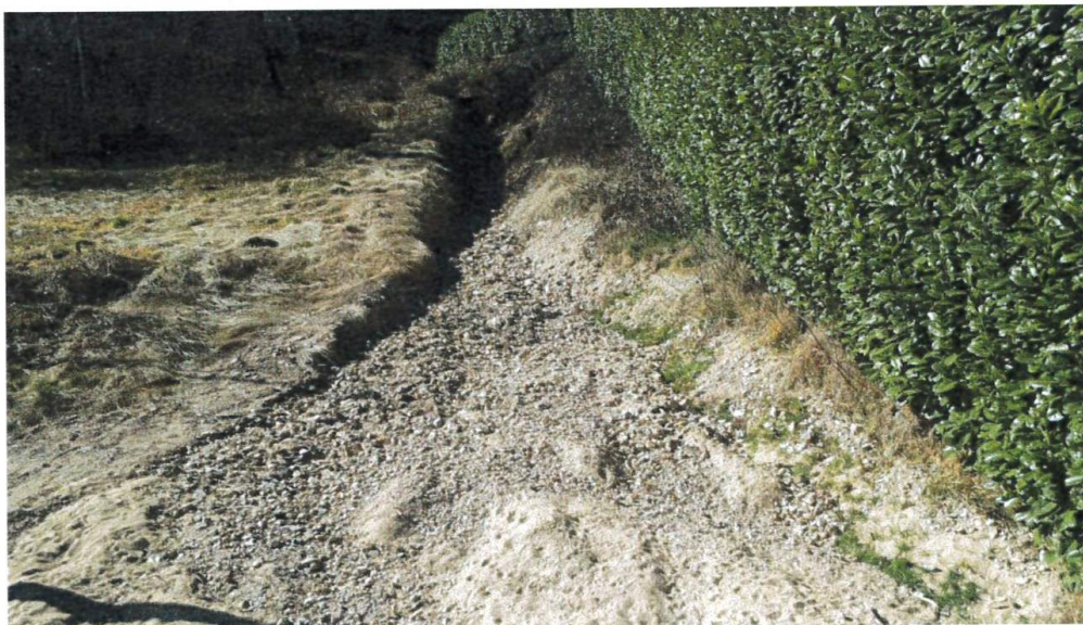
Deposito di materiale a monte di Via per Crevacuore – intervento 1
