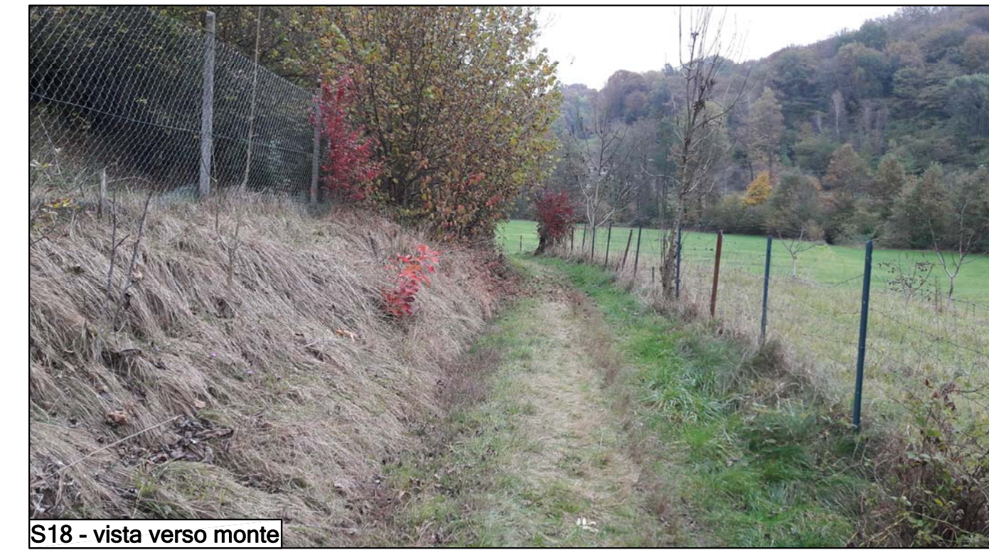
S18 - vista verso monte
