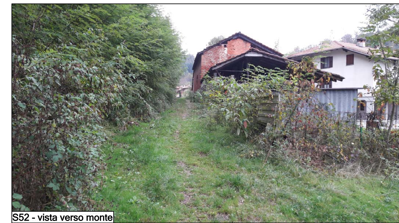
S52 - vista verso monte
