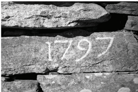
↑ Resti dell'edificio per il ricovero dei minatori, da Ferraris, cit. [cfr. parte 1 nota 67], p. 72.
