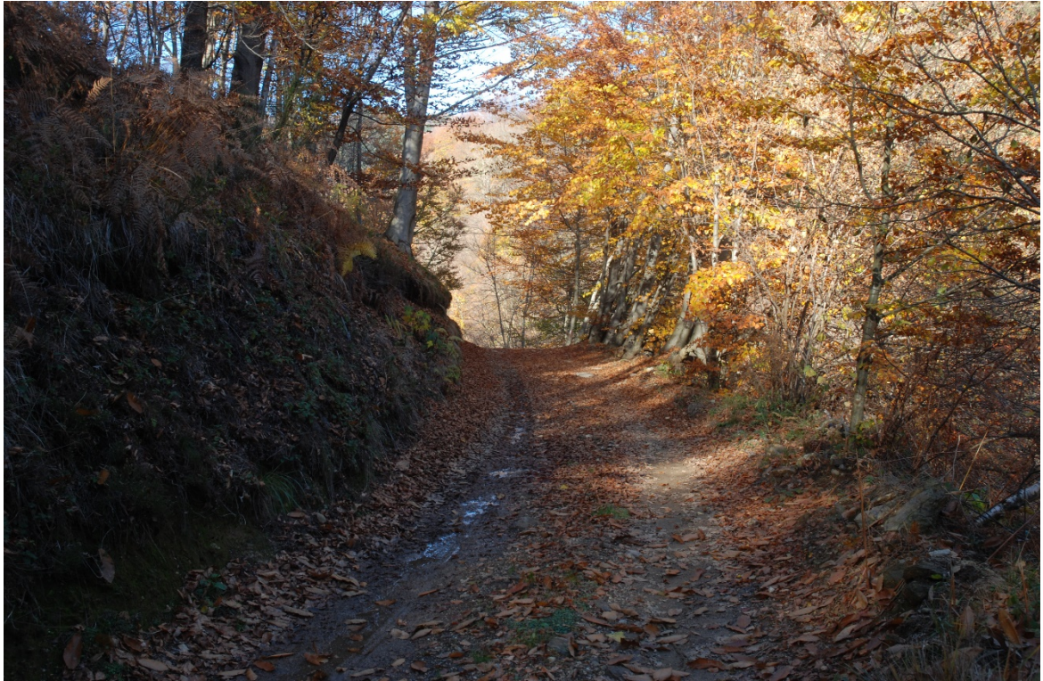
Fig. 4 Foto esemplificativa della prima parte del tracciato lungo la pista esistente
